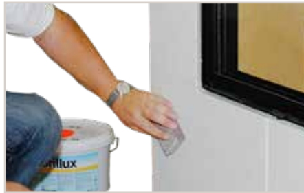
Unebenheiten nach dem Trocknen mit dem Schleif-Schwamm angleichen.
