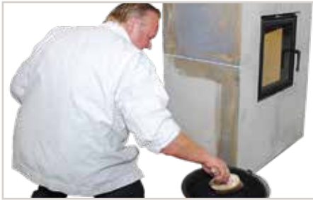
Silikat-Grund ELF 1803 1:1 mit Wasser verdünnen und gleichmäßig auftragen.
