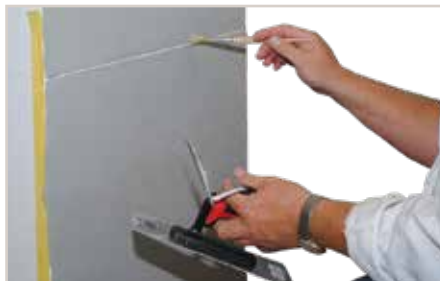
Fugen mit Pinsel nachziehen um ein gleichmäßiges Fugenbild zu erreichen.
