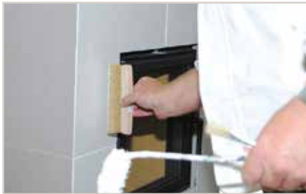
...und die gewünschte Struktur mit dem Deko-Wischer erstellen.
