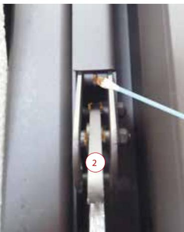
2. Ouvrez la porte et appliquez un peu de pâte de lubrification sur le coton-tige. Appliquez-la entre le rouleau de verrouillage (2) et l'axe de retenue et lubrifiez le ressort (voir l'image ci-dessus).
